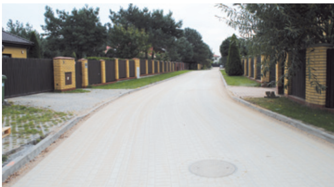
Osiedle Nasz Dom – prace budowlane i nowa nawierzchnia
