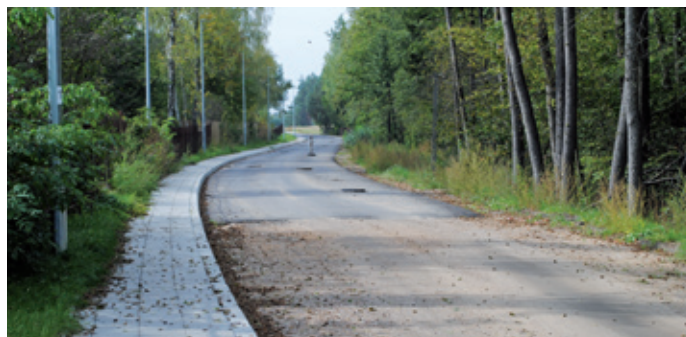
Budowa drogi – Księżyno-Kolonia
